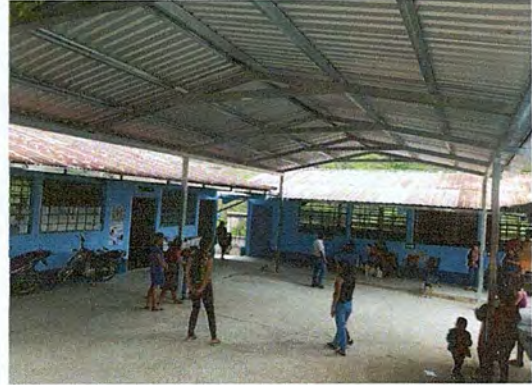
Foto 2: Mejoramiento de patio con Estructura portante a metalica (tipo portico) mas lamina troquelada calibre 26 para reuniones y actividades
