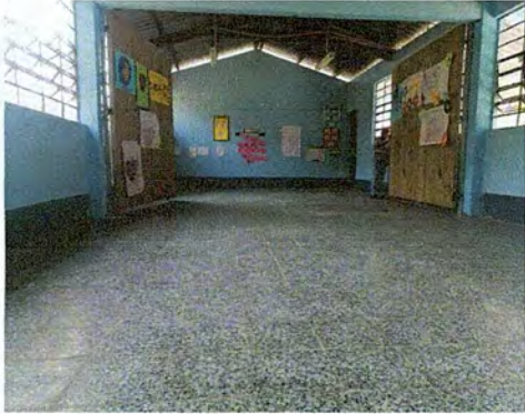
Foto 1: Mejoramiento de piso de aula polifuncional
