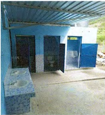
Foto 3: Mejoramiento de los servicios sanitarios.
