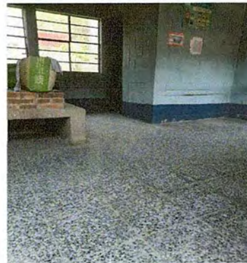
Foto 4: Mejoramiento de piso a la cocina
